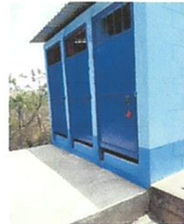
Foto 2: mejoramiento de modulo de sanitarios
