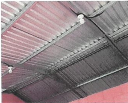
Foto 5: mejoramiento del techo y sistema electrico
