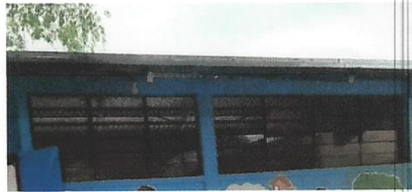
Foto 6: instalacion de canal para agua
